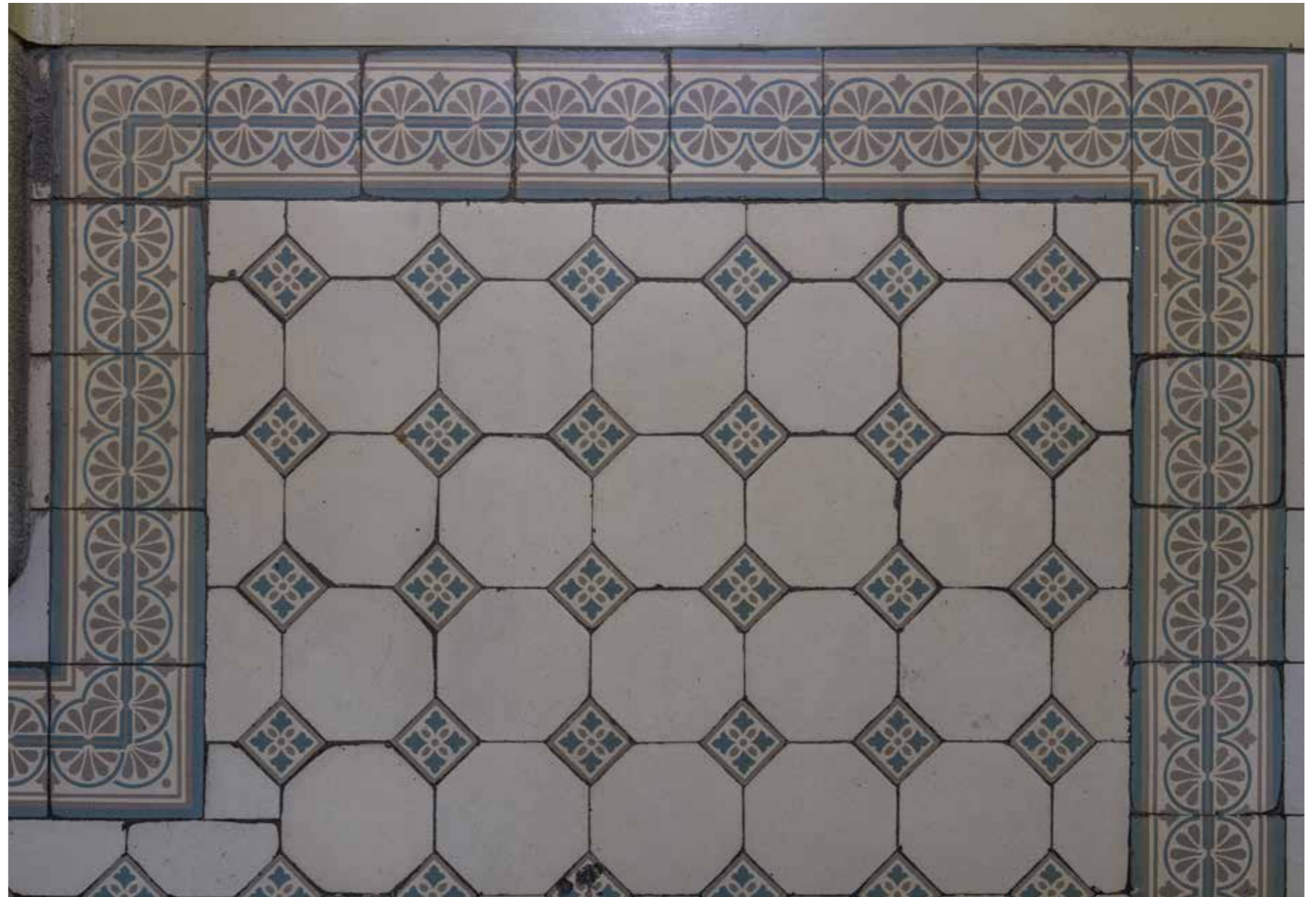
Popločenje podesta u stubištu
