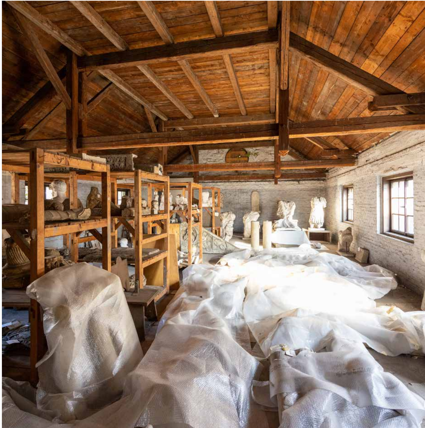
Južna zgrada Antika, krovšte južnog krila
