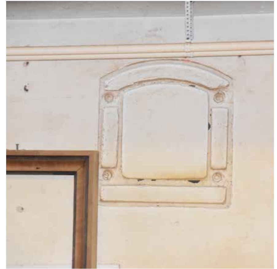
Željezni otvor, zapadna zgrada
