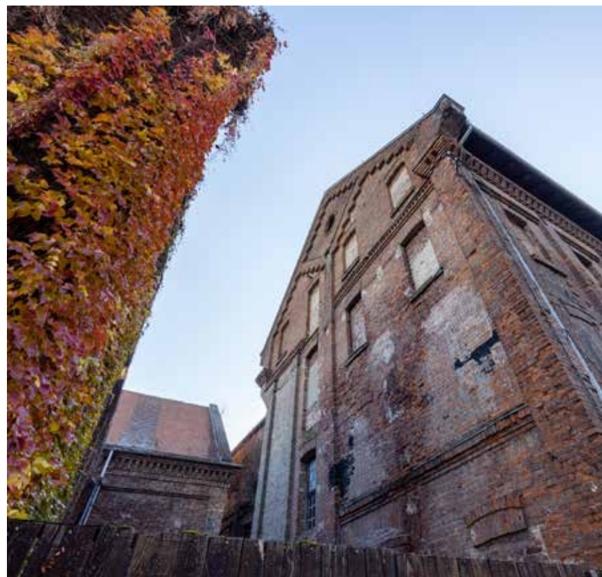
Zapadna ulična zgrada, pogled na sjeverno pročelje
