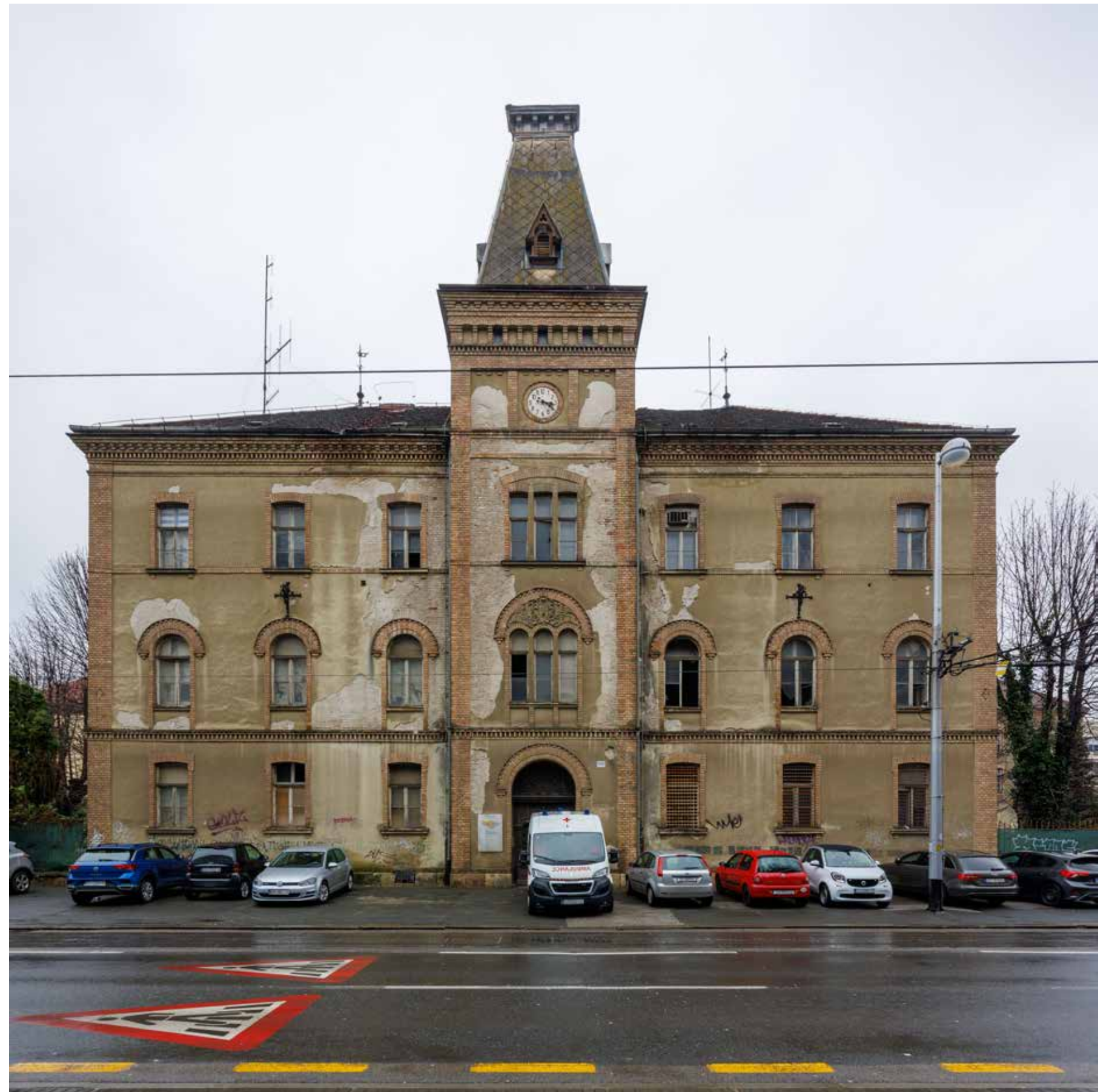
Zgrada pisarnice, južno pročelje
