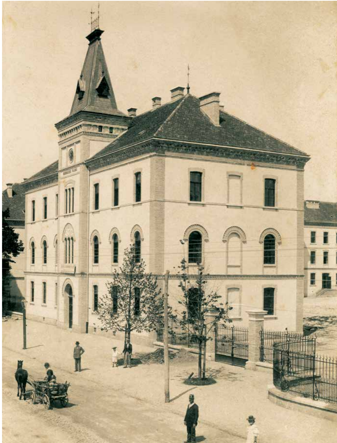
Domobranska vojarna, zgrada pisarnice, snimka s početka 20. stoljeća
