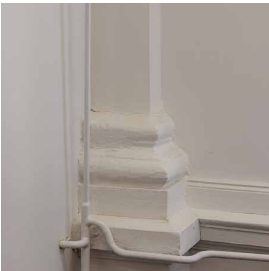
Baza pilastra svečane dvorane
