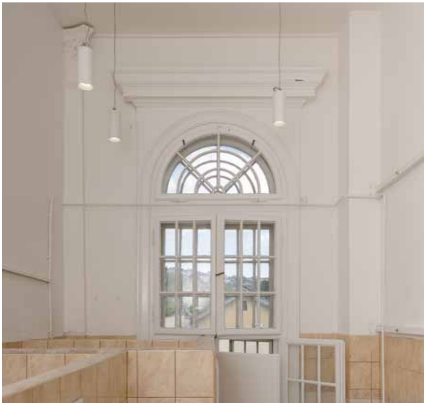
Dekoracija nekadašnje svečane dvorane u današnjim sanitarnim prostorijama
