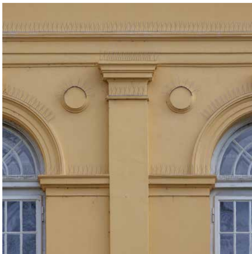
Toskanski pilastri na drugom katu južnog pročelja
