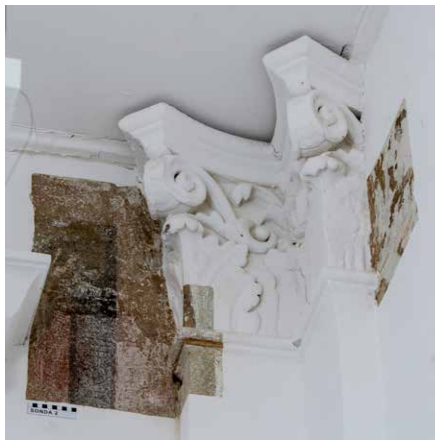
Oslici u svečanoj dvorani otkriveni restauratorskim sondiranjem
