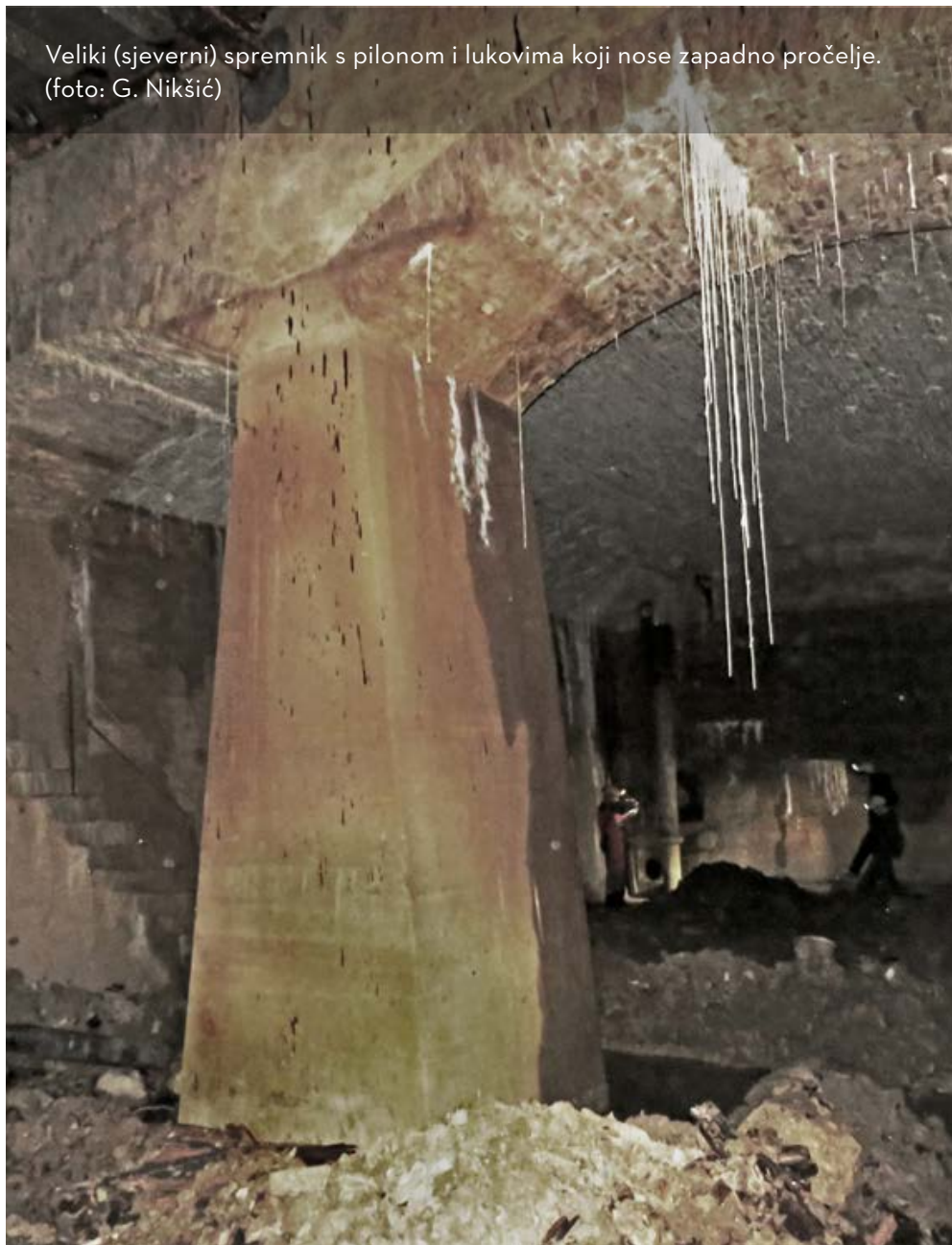
Veliki (sjeverni) spremnik s plitkim svodom u kojemu se vidi o tvor za ventilaciju. (foto: G. Nikšić)
