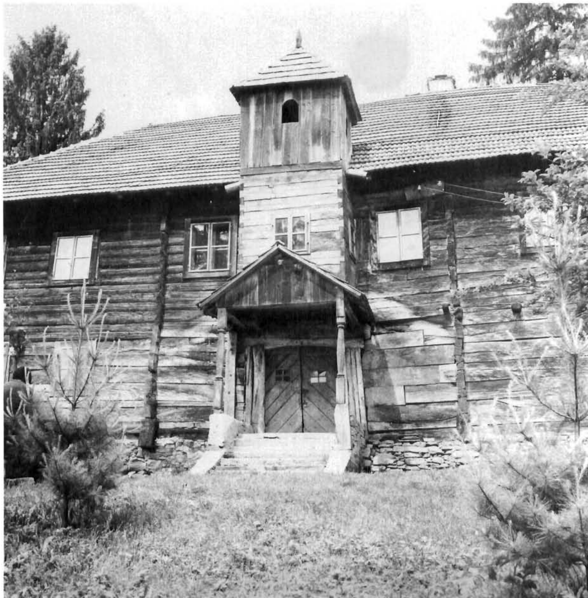
Dvorac Škaričevo Gornje, pročelje Škaričevo Gornje, facade
