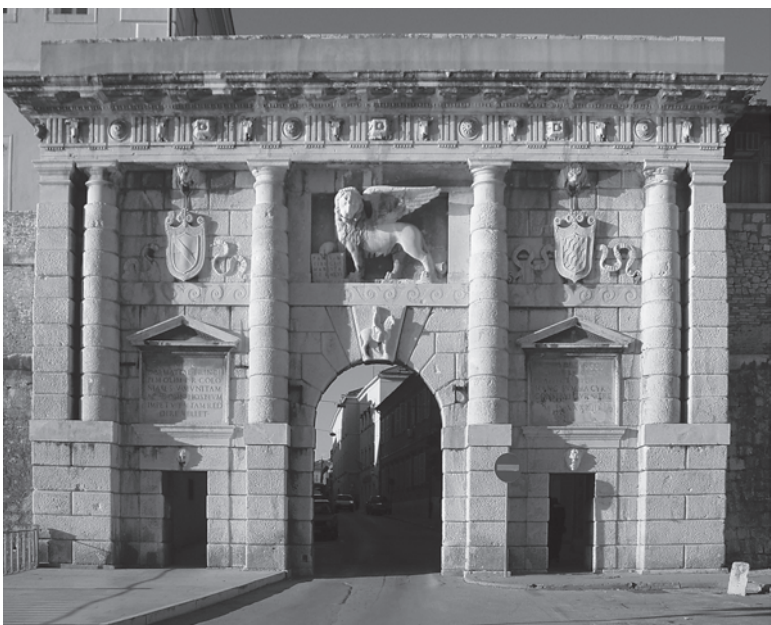
Pročelje Porta terraferma u Zadru, 1543. g. (foto: P. Vežić) Front façade of the Porta terraferma in Zadar, 1543
