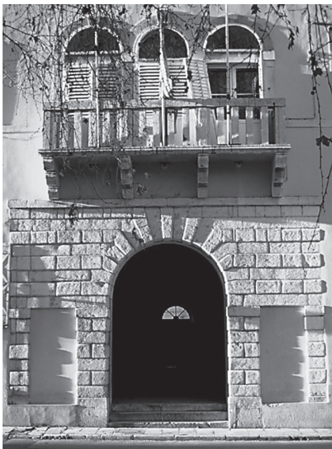
Portal na pročelju Providurove palače u Zadru, 1607. g. (foto: P. Vežić)
