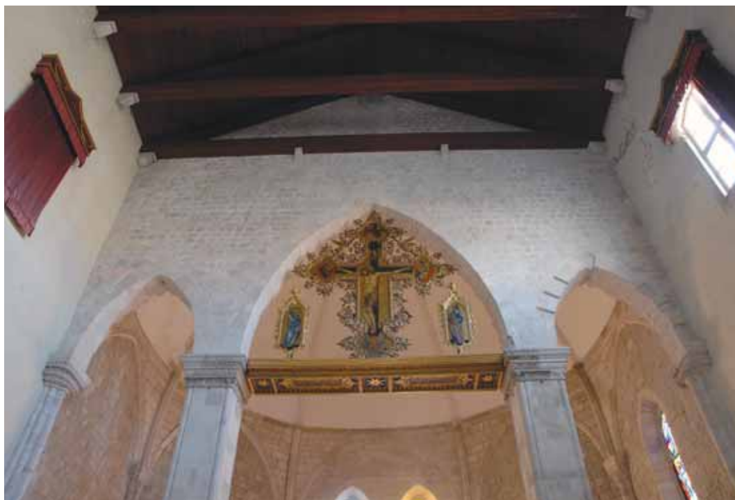
11. Dubrovnik, Crkva sv. Dominika, trijumfalni luk s konstrukcijom apside
