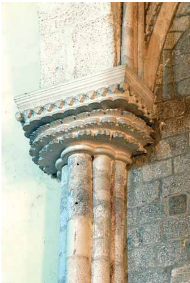
9. Dubrovnik, Crkva sv. Dominika, kapitel otvora začelnog zida lađe
