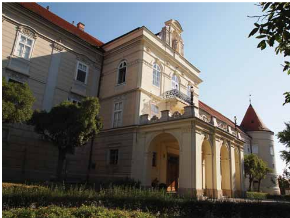
7. Glavno pročelje nadbiskupskog dvora, današnje stanje (foto: D. Damjanović, 14. 9. 2011.)
