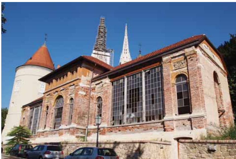
14. Staklenik u vrtu nadbiskupskog dvora, podignut 1881.–1882. po projektu H. Bolléa, današnje stanje (foto: D. Damjanović, 14. 9. 2011.)
