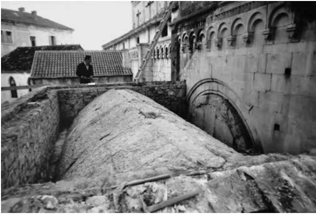
11 Krstionica trogirске katedrale prilikom izmjene krovišta 1979. godine (Arhiv konzervatorskog zavoda u Splitu)
