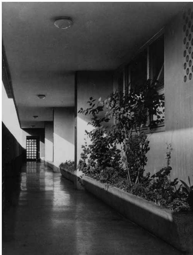
15. Drago Galić, Stambena zgrada u Ulici grada Vukovara 35–35a, galerija (HAZU-HMA-OAF DG, Fotoarhiva)
