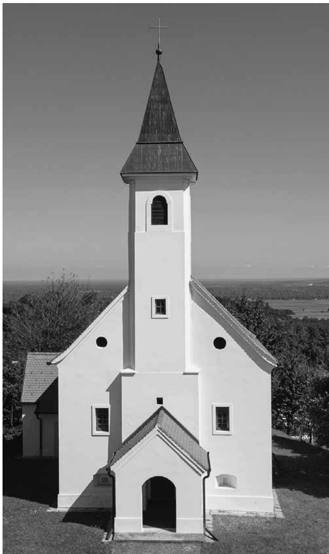
3. Crkva sv. Margarete na Kapelščaku, pročelje (foto: Andrej Švoger) Church of St Margaret in Kapelščak, façade
