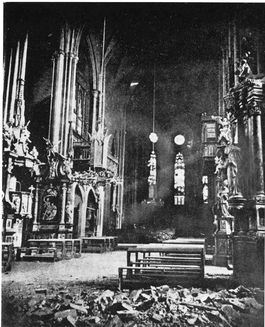
Zagreb, unutrašnjost katedrale nakon potresa 1880.
