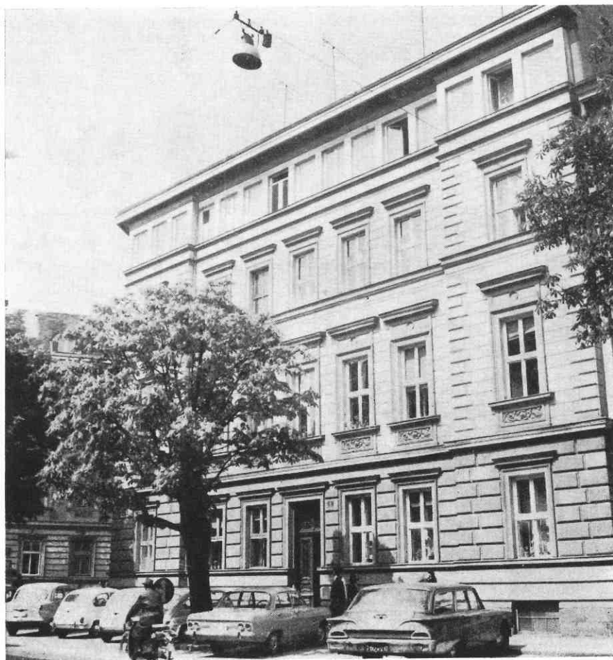
Na uglu Gajeve i Kavurićeve ulice dvokatnicu arh. Jambriškova (1879) dogradio je arh. Planić (1957) treći kat za uredske prostore. Ravnomjernim ritmom prozorskih otvora dogradnja ne imitira raspored donjih, ali kat u cjelini s istaknutom strehom djeluje kao proporcijски skladan završetak stare fasade.
