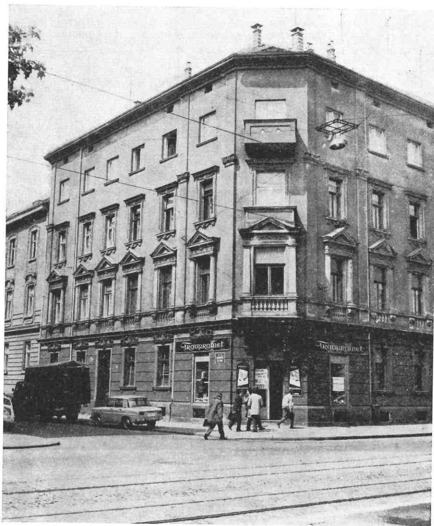
Metrička analiza kompozicije fasada neophodan je preduvjet za proračun sukladne mjere dogradnje u cjelini i njene unutrašnje podjele. Proporcijski sustav otkriva strukturu koja mora biti poštivana u dograđenom dijelu zgrade, što je mnogo važnije od proste imitacije i mehaničke repetitije formata svijetlih otvora.
